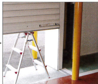
障害物が当たるとシャッターは 停止・反転上昇し停止します。
